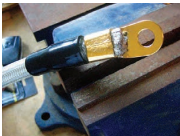
شکل ۳۱-۲ استفاده از گیره‌ی فلزکاری برای پرچ بست در روی کابل
