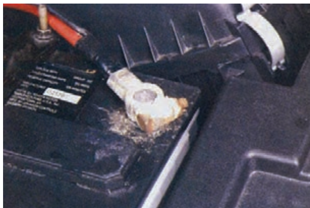
شکل ۸-۳۱ سولفات شده شدن اتصال قطب باتری
